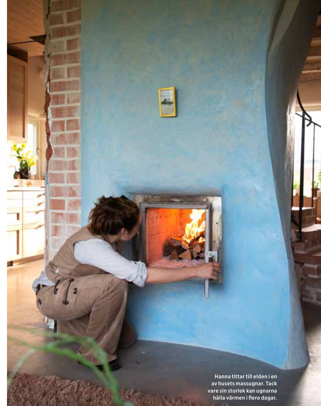
Den murade trappan är hopbyggd med två massugnar och utgör mittenpjäs på bottenvåningen i husets murade del.
